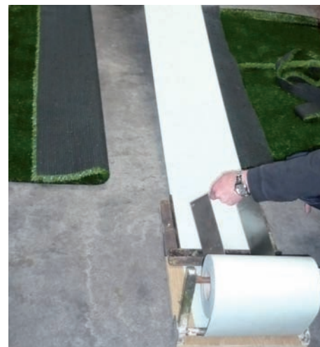
La pose du gazon est facilitée grâce aux accessoires proposés par TenCate, tels que les bandes de jonction autocollantes et les piquets de fixation.
